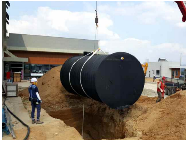
그림 3.4 빗물탱크 설치 사례(서울시, 2022)
