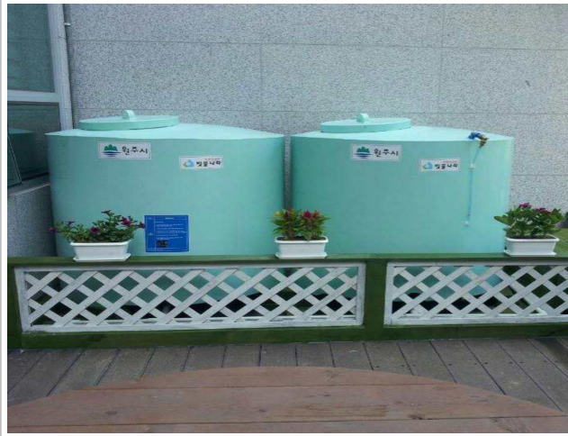
그림 3.4 빗물탱크 설치 사례(서울시, 2022)
